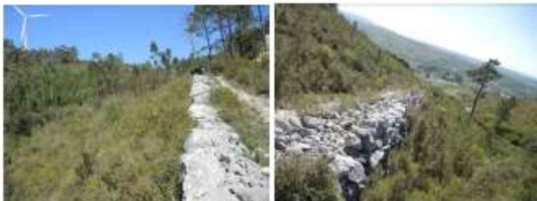
Caminho sustentado por espessos muros em pedra seca.
